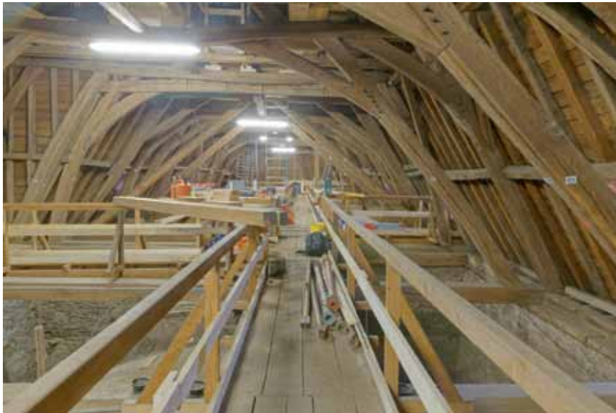
Blick auf die Baustelle im unteren Dachbereich.
